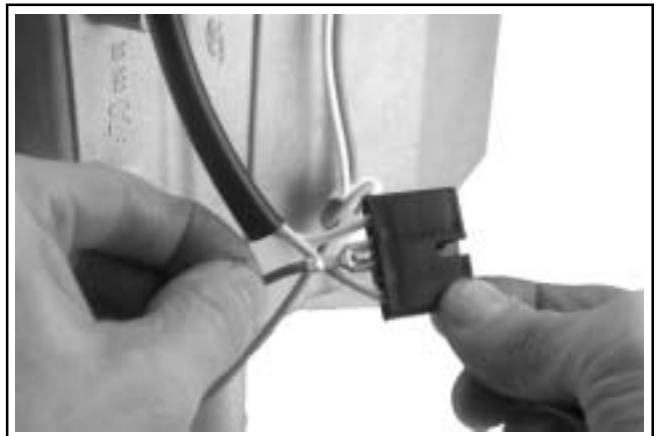
Kuva 10-43. B+ johdon asennus liittimeen.
